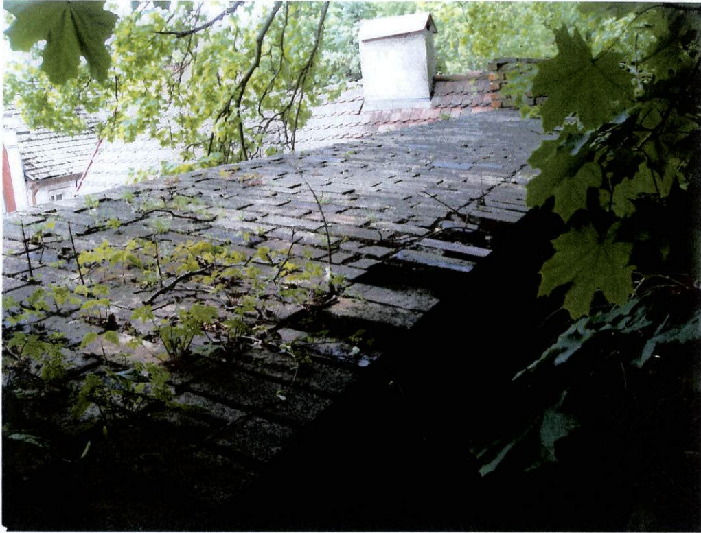
fot.23. Mur południowy – widoczna korona muru z ubytkami cegły oraz licznymi i głębokimi ubytkami zaprawy. Na koronie liczne porosty trawą.
