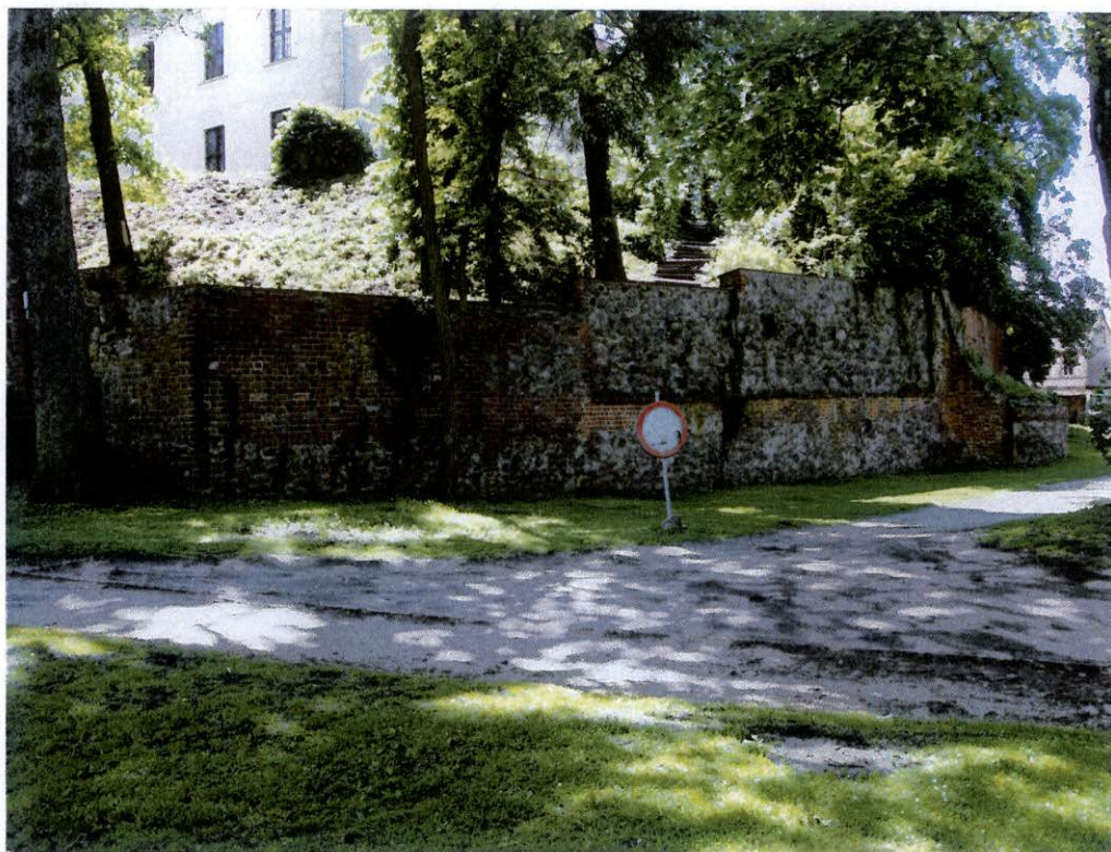
fot.47. Mur zachodni – widok części północnej. Mur o zróżnicowanej wysokości, częściowo z kamienia łamanego i otoczków, częściowo z cegły. Miejscami na murze nieliczne porosty.
