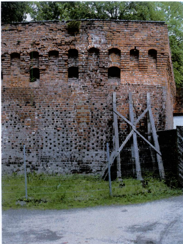
fot.1*). Naroże południowo – zachodnie – po prawej stronie mur południowy, po lewej mur zachodni. W murze południowym widoczne pionowe i ukośne pęknięcia, górą muru liczne cegły skorodowane z głębokimi ubytkami. W murze zachodnim, w połowie wysokości, jest widoczne znaczne odkształcenie na zewnątrz, będące przyczyną pionowego pęknięcia w pobliżu naroża w murze południowym.
