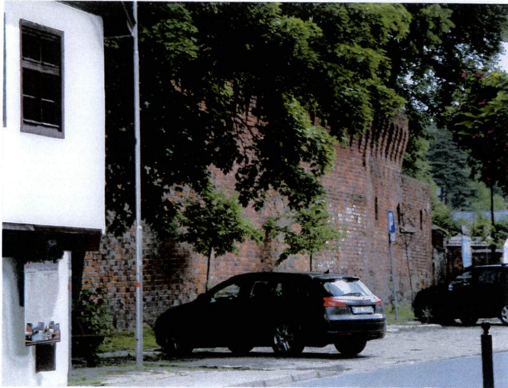
fot.15. Mur południowy – w widoku od strony ulicy Kościuszki. Po lewej stronie budynek przybudowany do muru.
