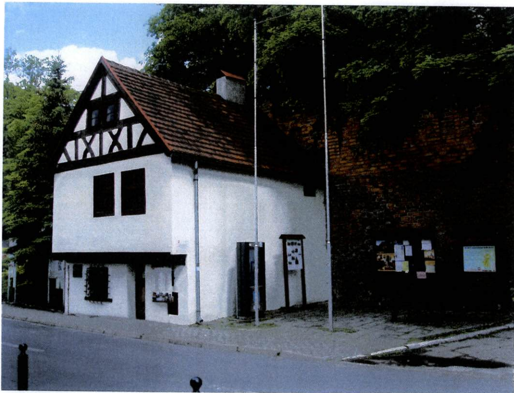
fot.16. Mur południowy – widoczny późniejszy budynek, przybudowany do muru od strony południowej. Ściany budynku przybudowanego zabezpieczają mur południowy przed wychyleniem.
