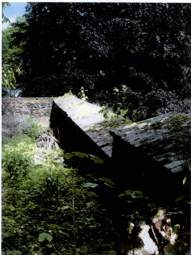
fot.35. Mur wschodni – mur w części północnej, w widoku od strony wewnętrznej. Widoczny wysoki poziom terenu po wewnętrznej stronie muru. Różnica poziomów terenu z obu stron muru jest spowodowana zmiennym poziomem terenu po stronie wewnętrznej muru. W skrajnym przypadku różnica poziomów dochodzi do około 4,60 m.
