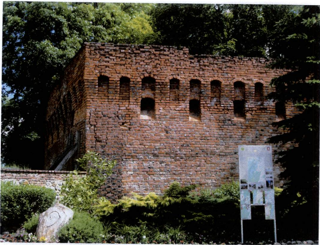
fot.1*). Naroże południowo – zachodnie – po prawej stronie mur południowy, po lewej mur zachodni. W murze południowym widoczne pionowe i ukośne pęknięcia, górą muru liczne cegły skorodowane z głębokimi ubytkami. W murze zachodnim, w połowie wysokości, jest widoczne znaczne odkształcenie na zewnątrz, będące przyczyną pionowego pęknięcia w pobliżu naroża w murze południowym.
