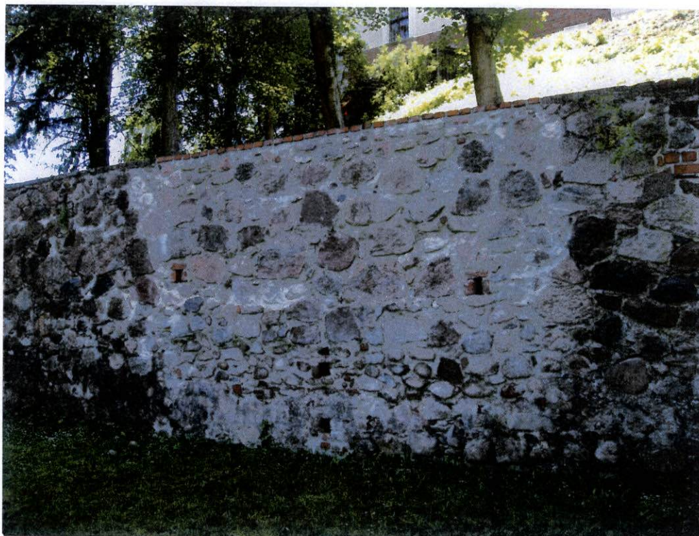
fot.41. Mur północny – fragment środkowy muru. Jak wynika z przekazów mur w tej partii runął przed kilku laty, w wyniku naporu gruntu i obfitych deszczy. Bezpośrednio po katastrofie odbudowano mur z kamienia łamanego, bez dbałości o dobranie kolorystyczne do istniejących sąsiednich historycznych partii muru kamiennego.
