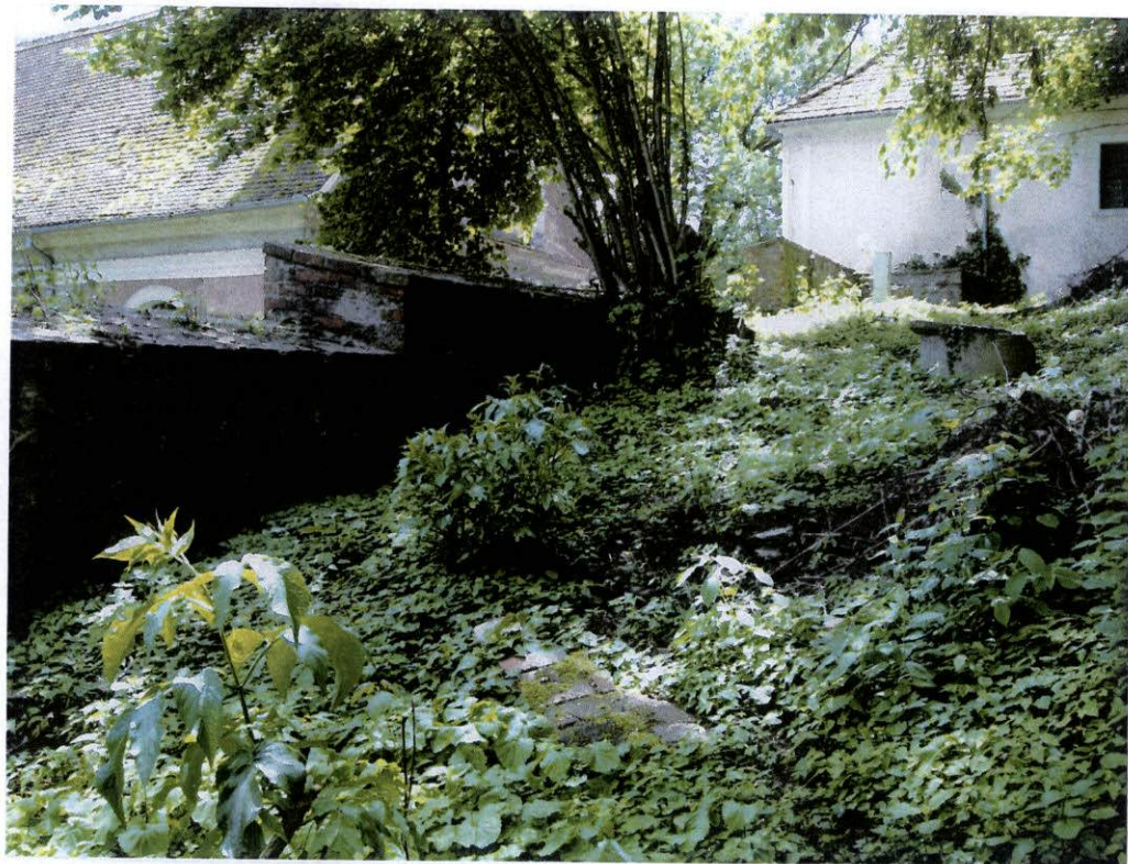
fot.35. Mur wschodni – mur w części północnej, w widoku od strony wewnętrznej. Widoczny wysoki poziom terenu po wewnętrznej stronie muru. Różnica poziomów terenu z obu stron muru jest spowodowana zmiennym poziomem terenu po stronie wewnętrznej muru. W skrajnym przypadku różnica poziomów dochodzi do około 4,60 m.
