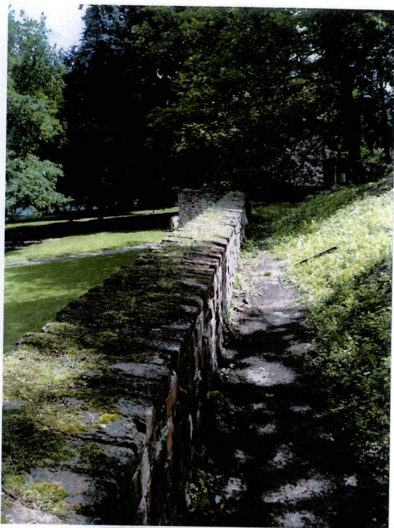
fot.43. Mur północny – środkowa partia muru w widoku od strony wewnętrznej. Poziom terenu widoczny na zdjęciu znajduje się około 3,00 m wyżej niż teren po zewnętrznej stronie muru, co skutkuje naporem gruntu na mur. Napór gruntu jest tu tym większy, że od muru w kierunku zamku jest stromy stok wzgórza zamkowego, co widać na fragmencie po prawej stronie zdjęcia.
