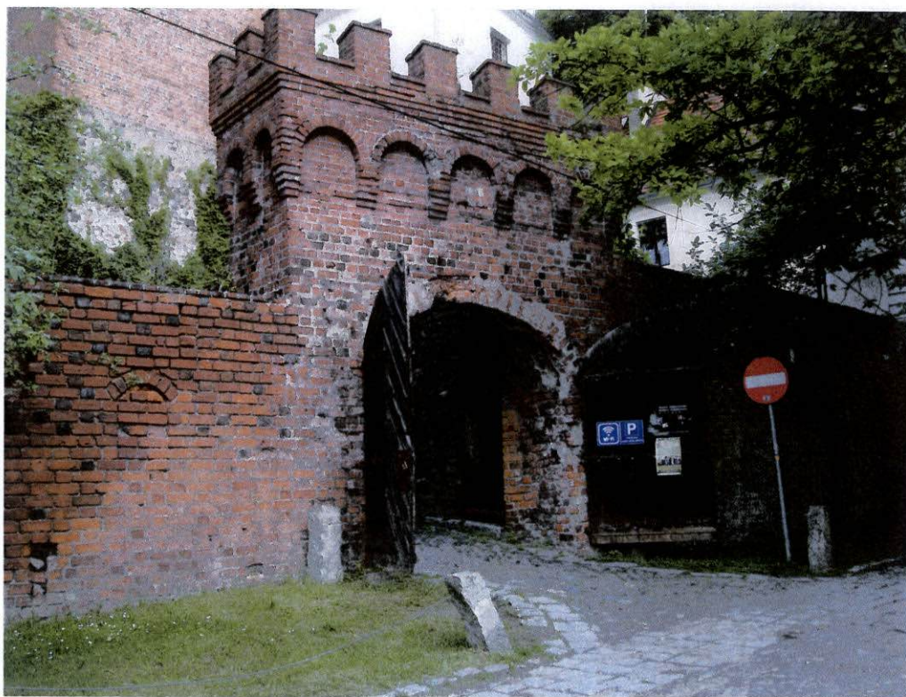
fot.25. Mur wschodni – brama wjazdowa na teren zamku, w linii muru obronnego, w widoku od strony zewnętrznej. W kluczu łuku bramnego widoczny niewielki ubytek. Po lewej stronie mur z cegły.
