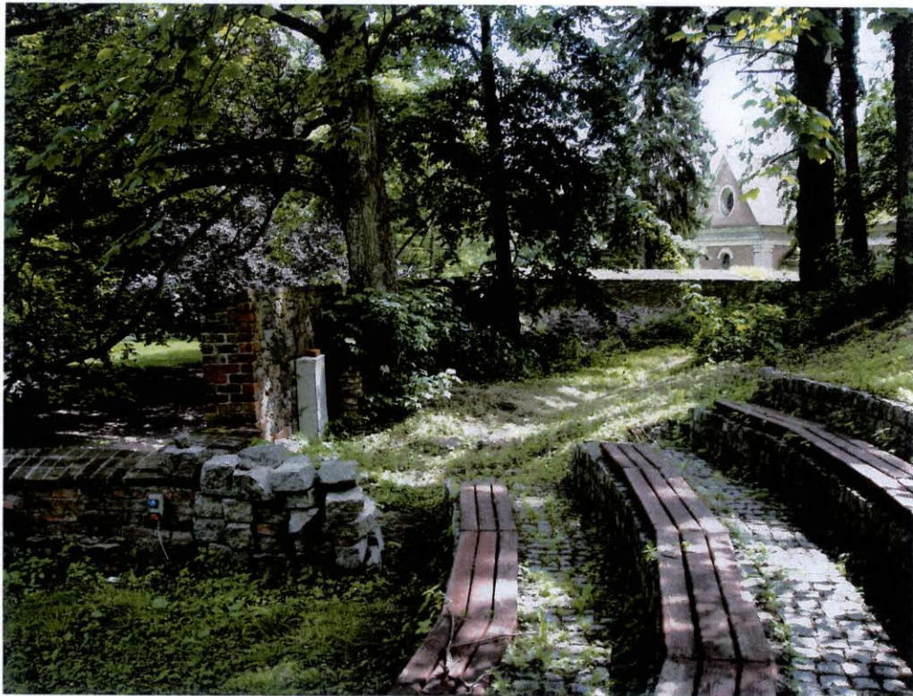
fot.46. Mur północny – w głębi zdjęcia widoczna wschodnia część muru. Bliżej fragment muru bastionu o ceglach częściowo zniszczonych. Po prawej stronie ławki widowni amfiteatru.
