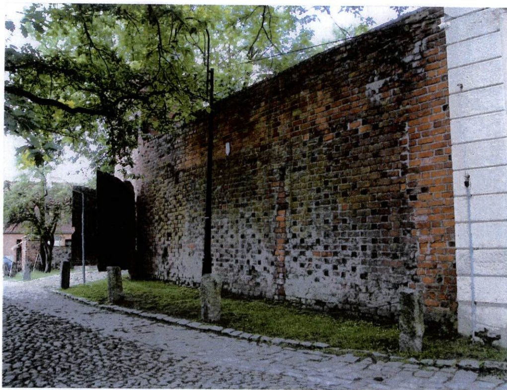
fot.29. Mur wschodni – środkowa część muru obronnego – między wjazdem i wejściem do zamku. Mur ceglany miejscami, głównie dołem i pod koroną o ceglach skorodowanych z ubytkami i o głębokich ubytkach skorodowanej zaprawy.
