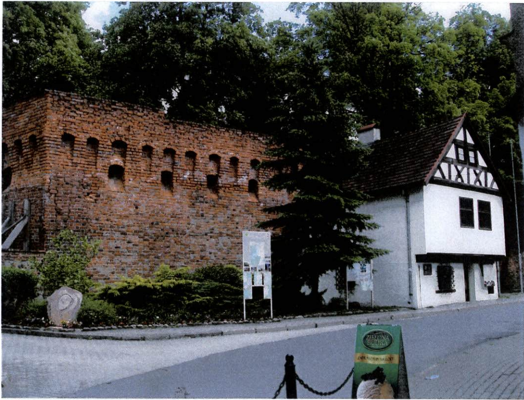
fot.5. Naroże południowo – zachodnie – mur południowy, w niewielkiej odległości od naroża, jest zabezpieczony przed wychyleniem przez ściany budynku przybudowanego.
