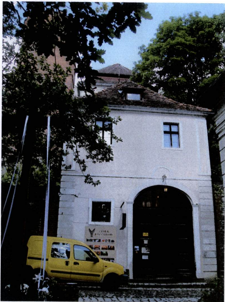
fot.27. Mur wschodni – XVII wiecna zabudowa schodów prowadzących do zamku – wejście do zamku (do hotelu). Widoczna ściana frontowa jest w licu muru obronnego wschodniego.
