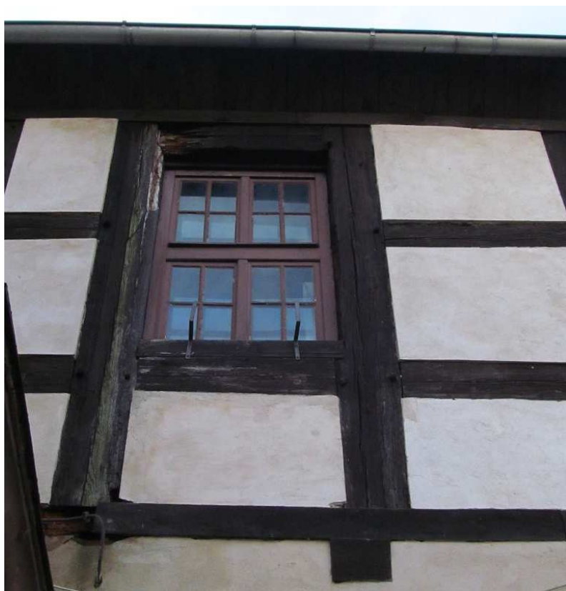
widoczny uszkodzony słupek i rygiel przy oknie w elewacji wschodniej
