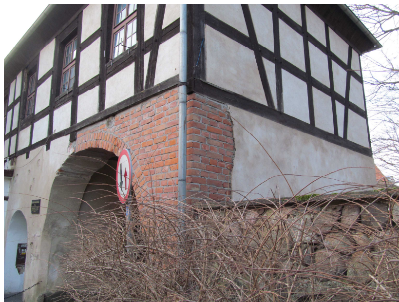
fragmenty ścian do uzupełnienia tynku zewnętrznego – stan styczeń 2024 roku
