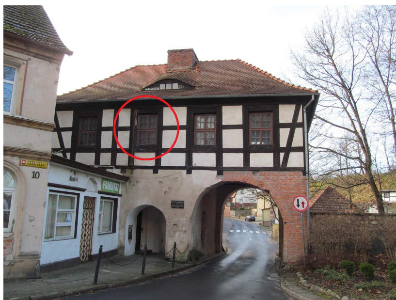
w elewacji wschodniej konstrukcja szachulcowa do naprawy
